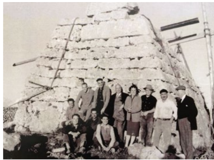
Maria L. Serra amb els obrers en la restauració de la naveta des Tudons 1959
